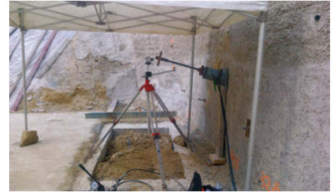
Soil nail tests, Méliá tower, La Défense
