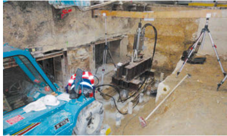
Micropile tests, Méliá tower, La Défense
