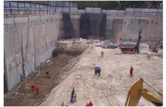
Freyssibar micropiles - Saint Régis Hotel - Argentina
