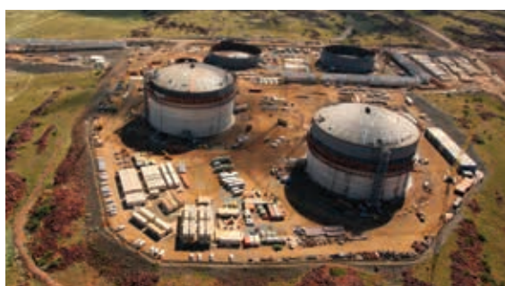
Pluto LNG, Karratha, Australia
